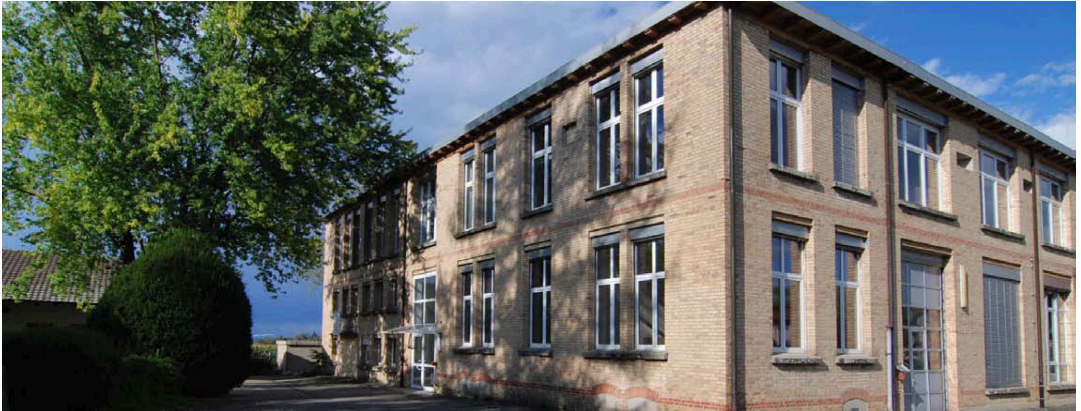
In dieser ehemaligen Textilfabrik in Fahrwangen entstehen 16 Lofts in der Grösse zwischen 126 und 276m 2 . Genug Platz also, um seinen ganz persönlichen Loft-Traum zu verwirklichen.
